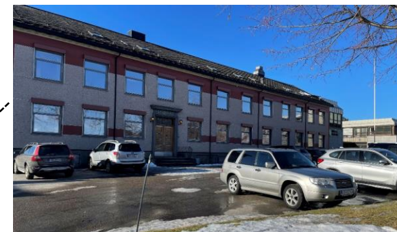
Parkeringsplassen ved kommunehuset
